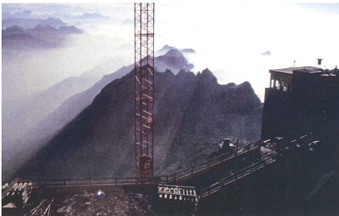
Baustelle auf dem Säntis
